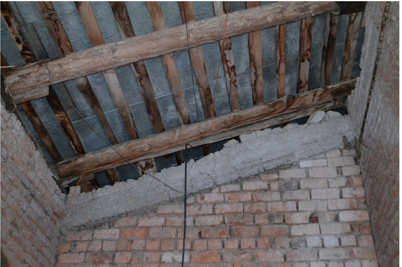
Фото 5. ЖБ перекрытие над некоторыми чердачными помещениями.
