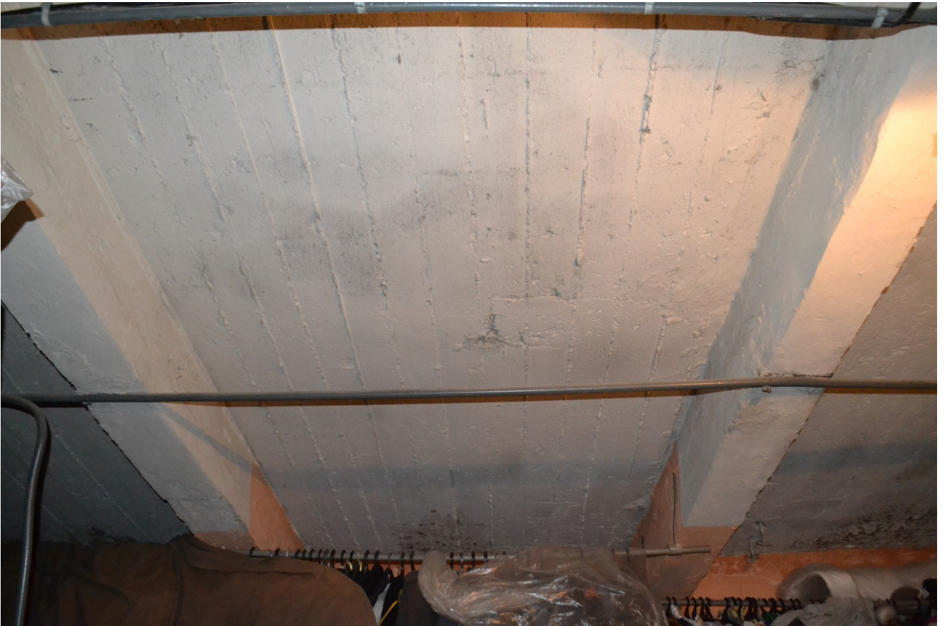
Фото 14. ЖБ перекрытие над калориферной.
