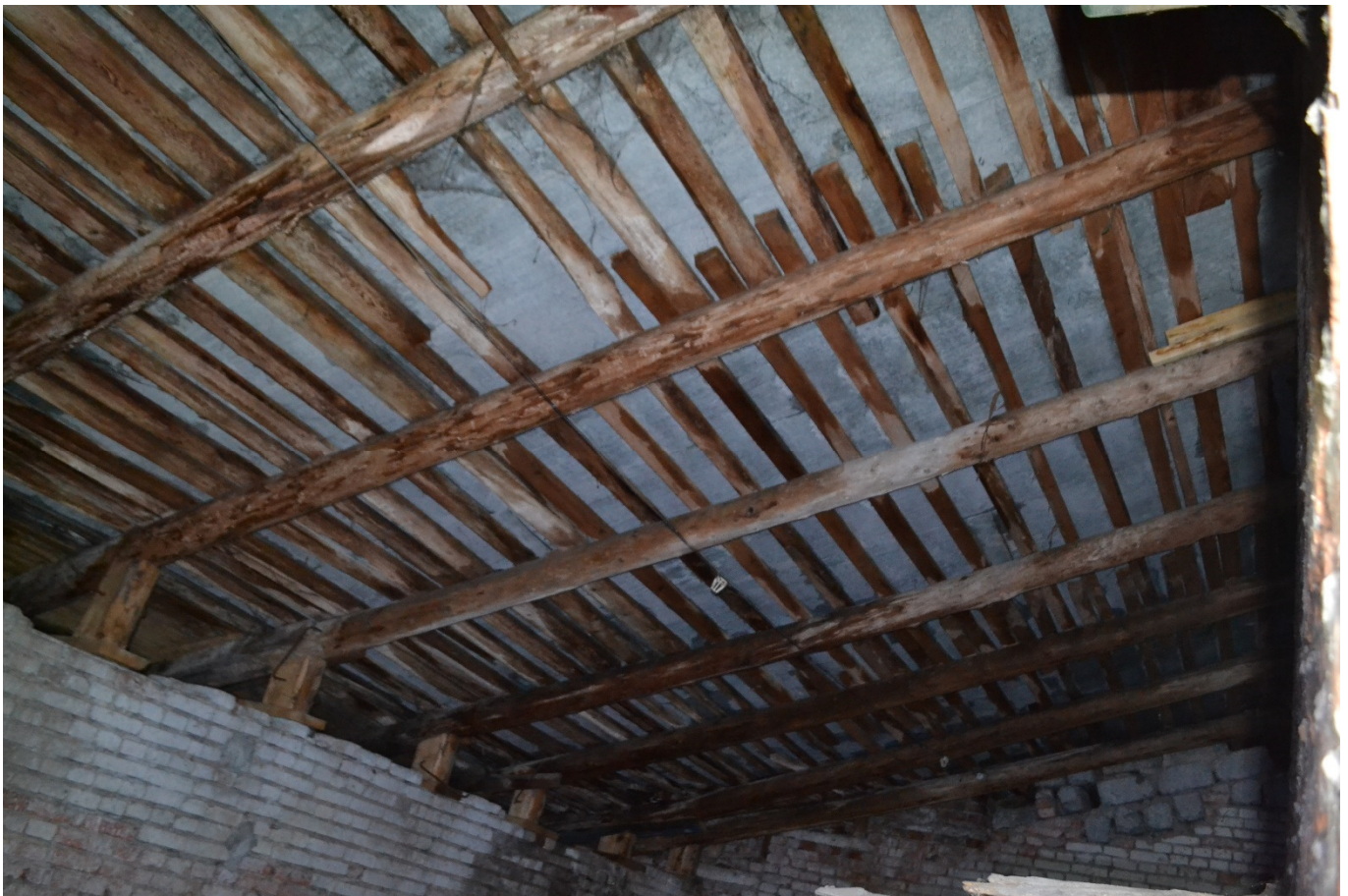
Фото 3. Стропильная система. Общий вид. Подпорки стропил.
