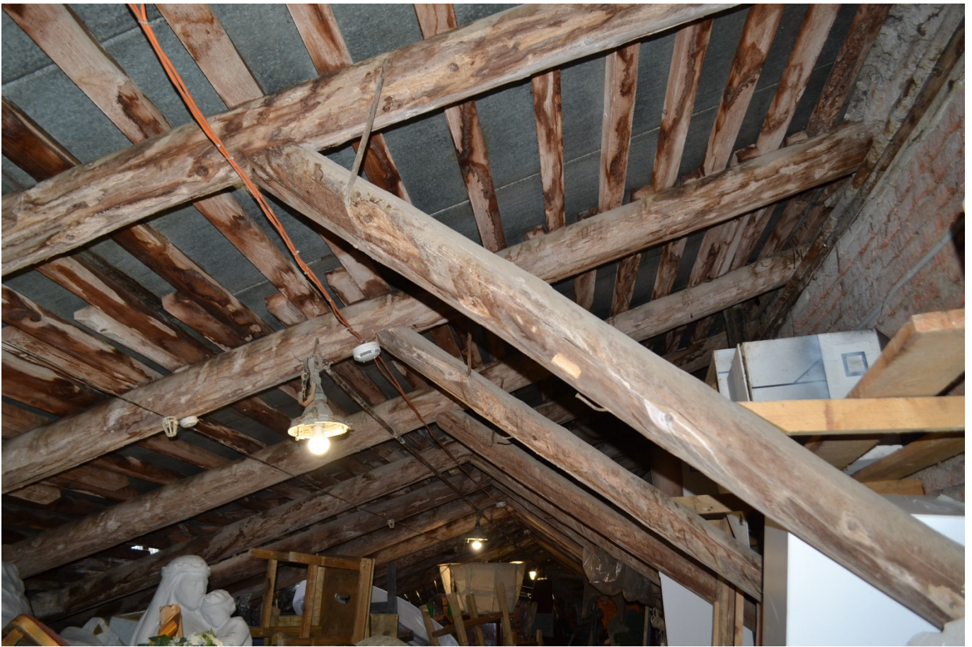
Фото 15. Чердачное помещение в осях 12-13/Д-Л.
