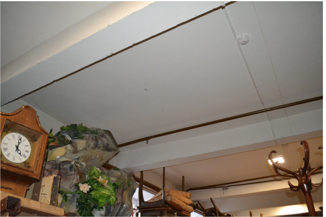
Фото 13. Чердачное перекрытие под помещением в осях 12-13/Д-Л.
