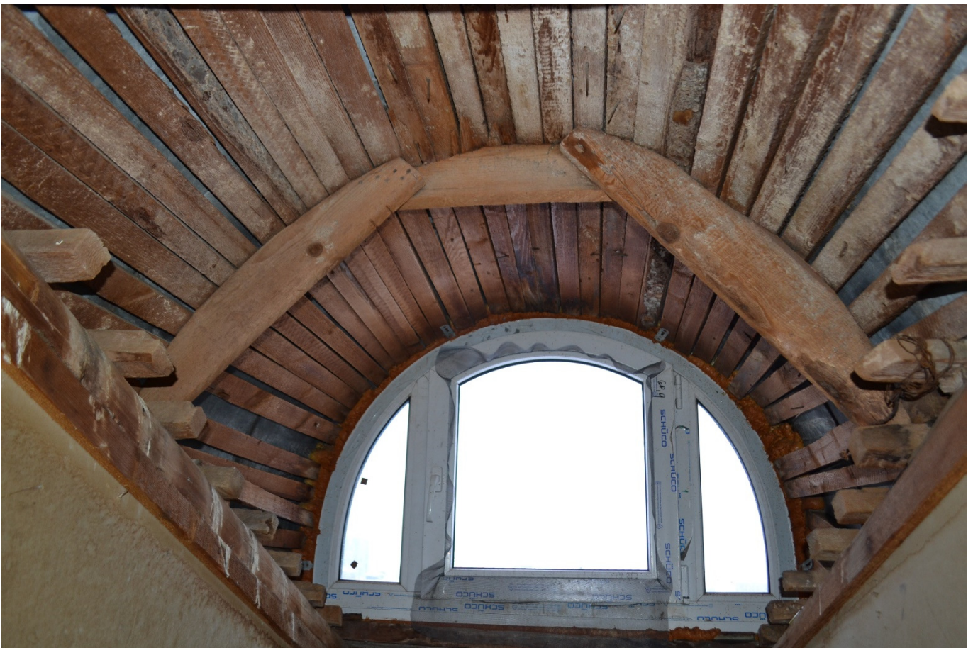
Фото 6. Слуховое окно выхода на кровлю.
