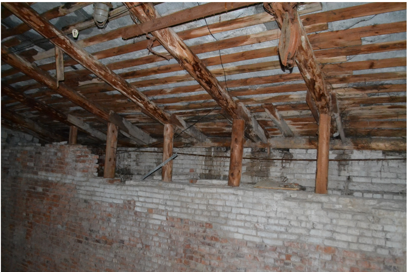
Фото 7. Подпорки стропил (зона в осях 1-3/).
