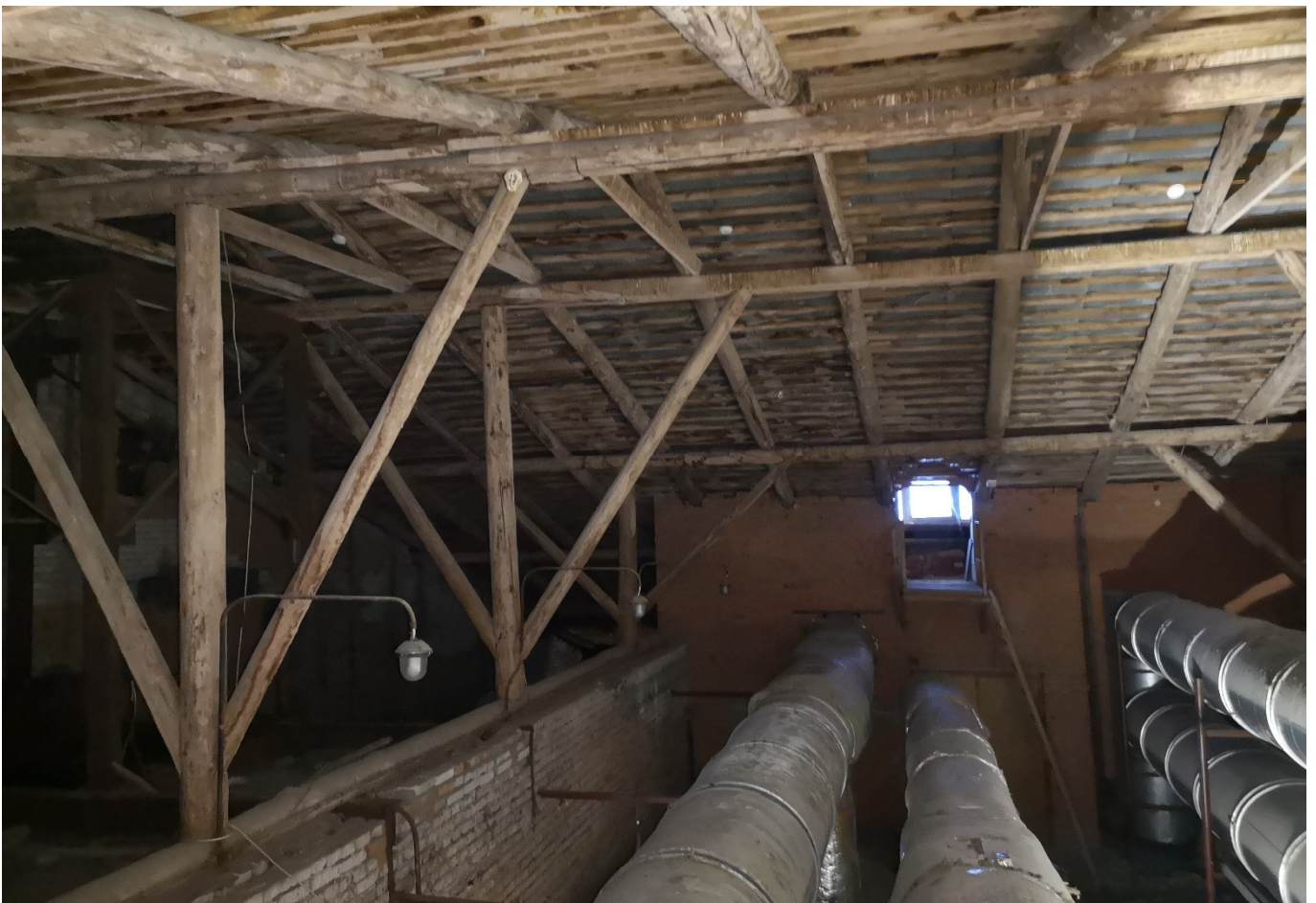
Фото 16. Стропильная система кровли. Общий вид.
