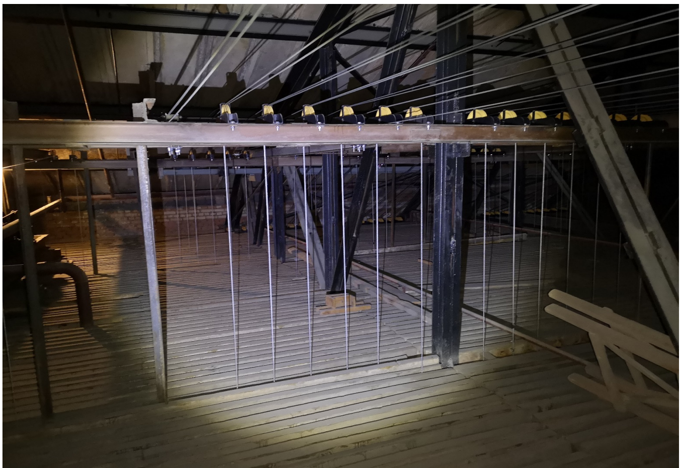
Фото 18. Помещение рабочей галереи.
