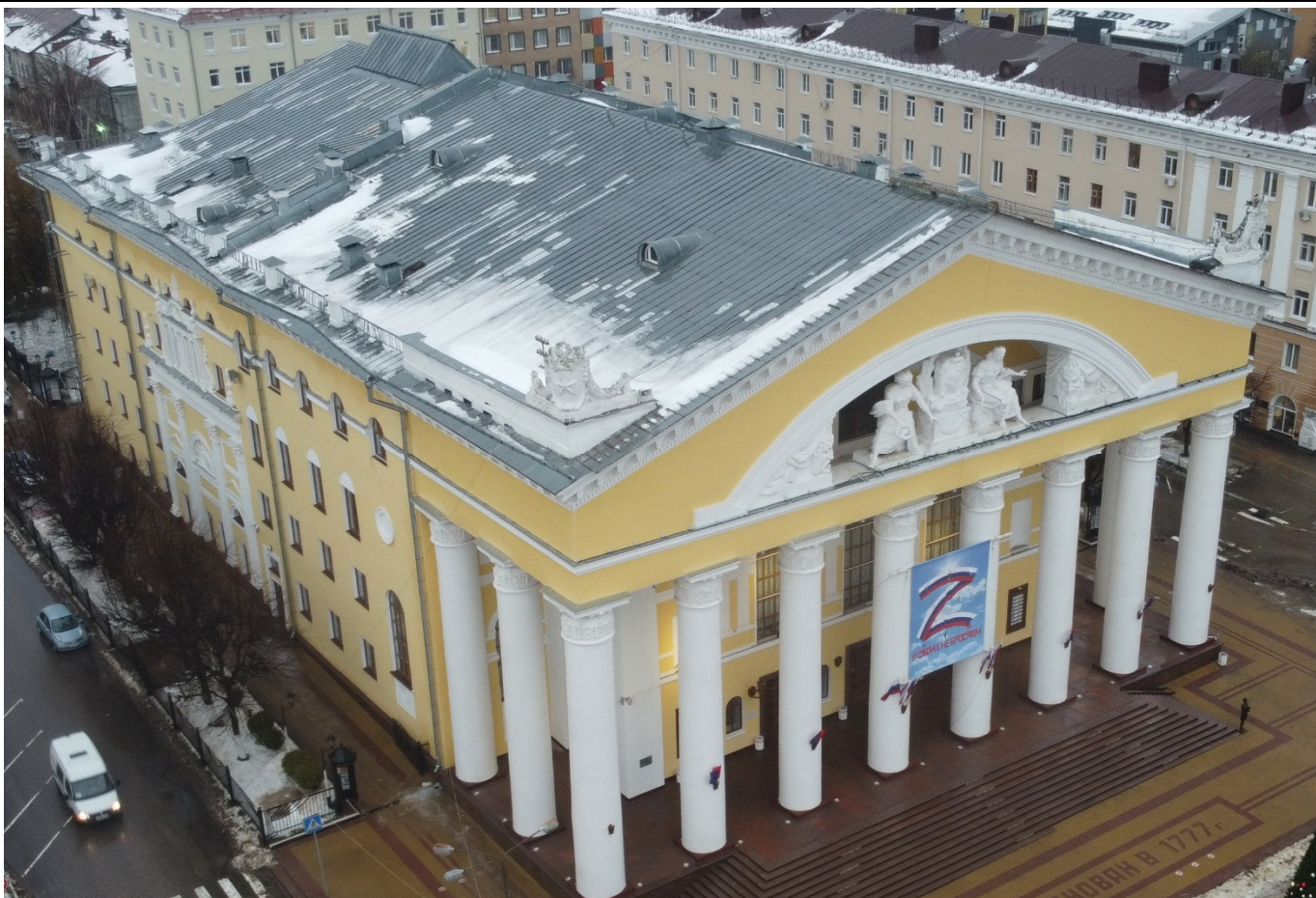
Фото 1. Кровля здания. Общий вид.
