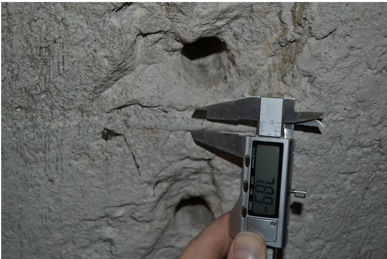
Фото 21. Измерение параметров армирования ЖБ перекрытия.
