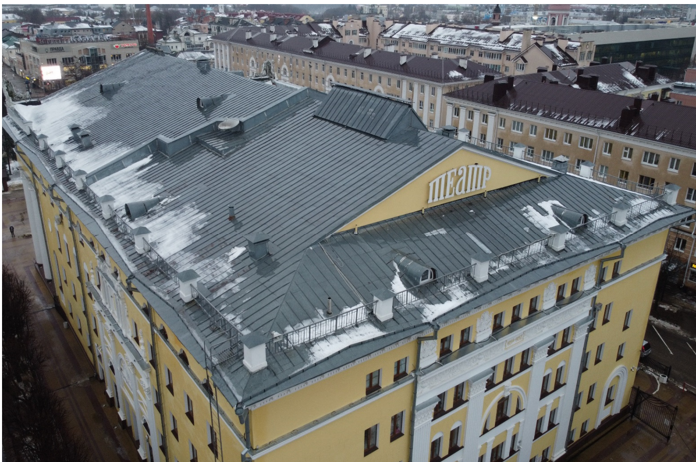
Фото 2. Кровля здания. Общий вид.
