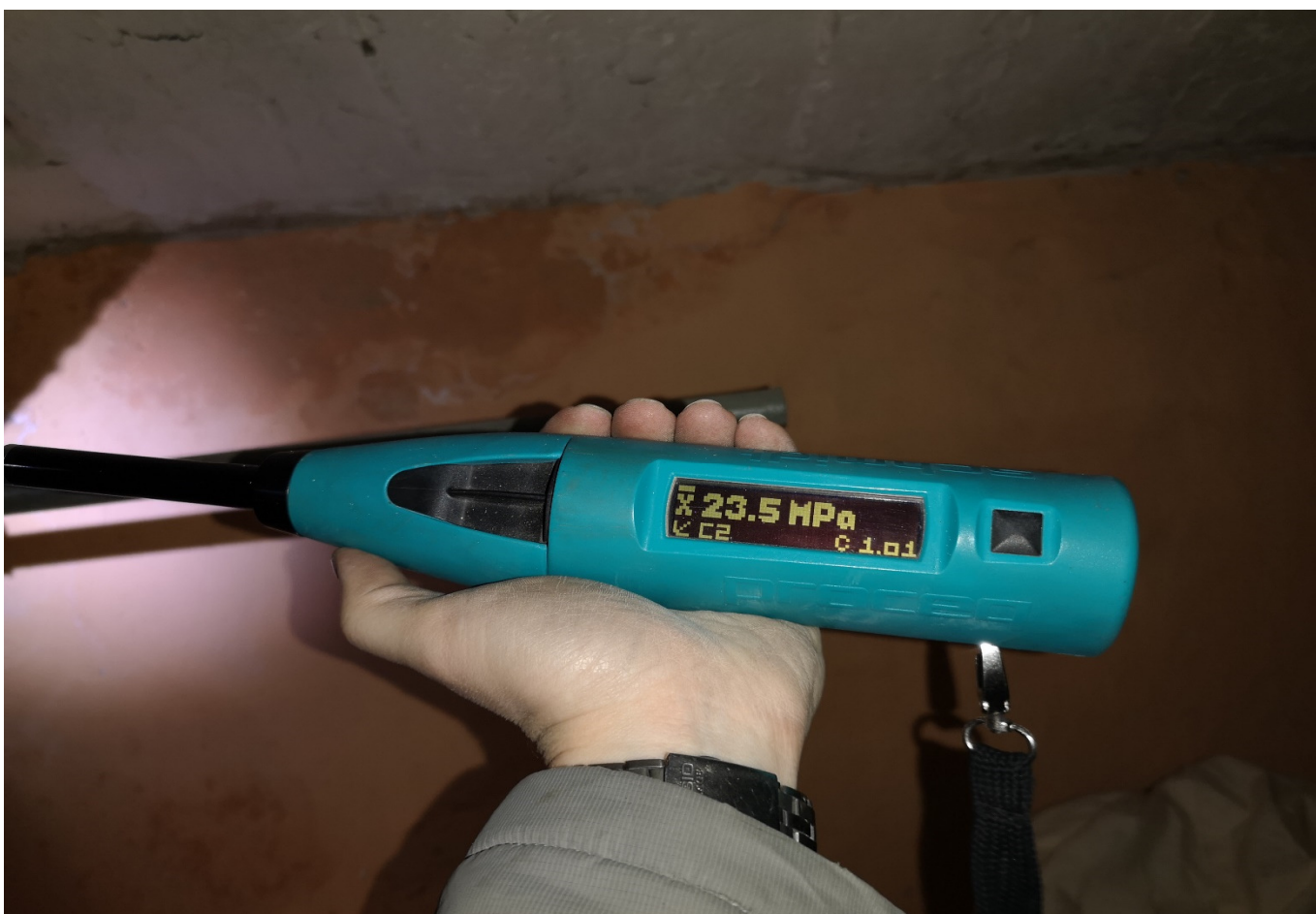
Фото 22. Измерение прочности бетона чердачного перекрытия.
