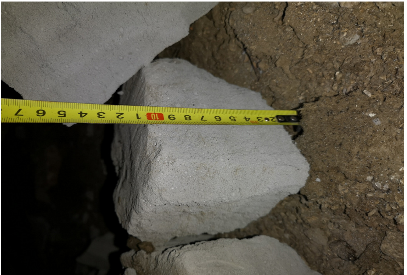
Фото 23. Измерение толщины утеплителя перекрытия над живоп. мастерской.
